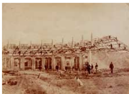
La rotonde des machines en construction (Photographie de Gondran)
