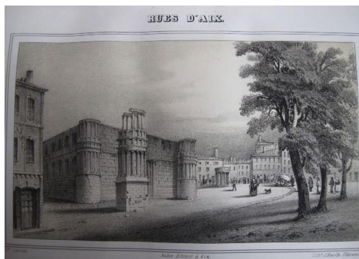
La démolition du Palais et des tours (la rotonde à droite est due à l'invention du dessinateur)
