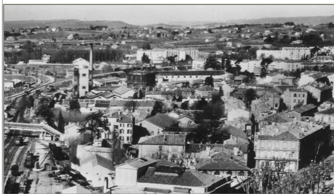
L'ouest aixois au milieu du XX e s. : importance du site de l'usine à gaz avec son grand gazomètre et sa haute cheminée.
